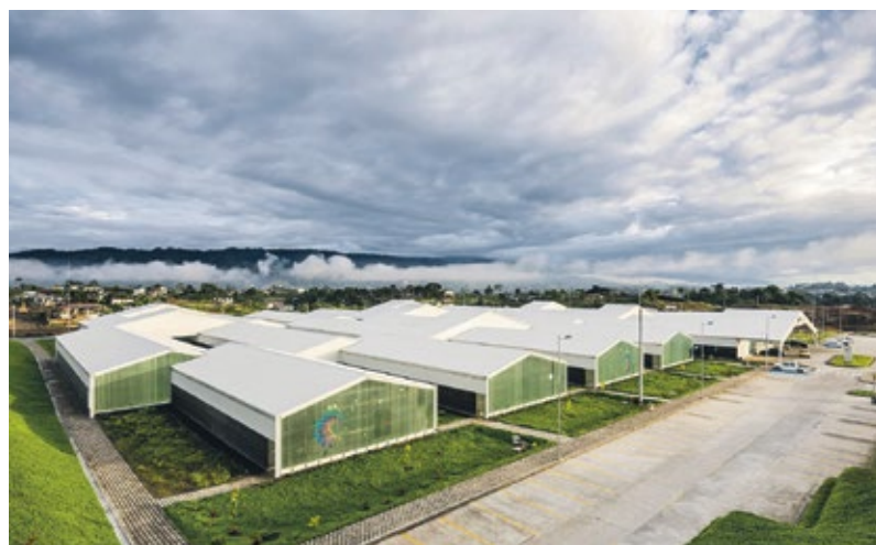
In Puyo, einer Provinzhauptstadt mitten im tropischen Regenwald, entstand ein modernes Krankenhaus. Auf 15.000 qm sind 21 Gebäude in drei Reihen angeordnet.
