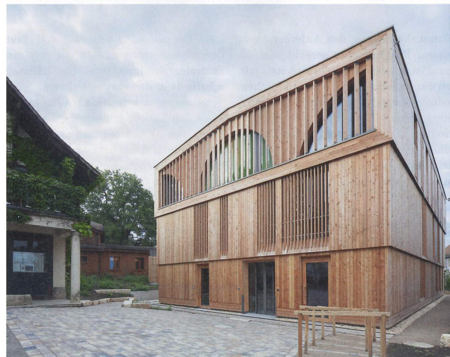
Das Heilmittelgebäude wurde 2023 in Massivholzbauweise aus Mondholz fertiggestellt. Es dient als Blaupause für den Klinikneubau.
