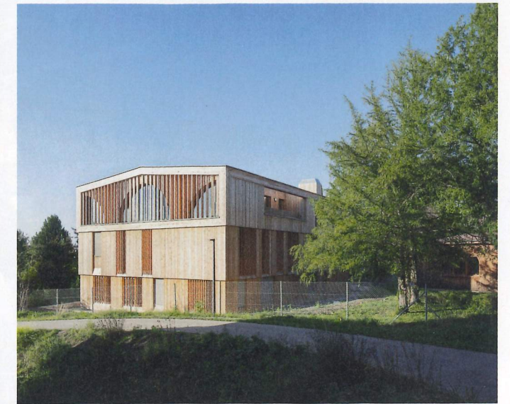
Das neue Heilmittellabor von der Rückseite. Die Parkanlage der Klinik Arlesheim wird im Zuge des Neubaus ebenfalls neugestaltet.
